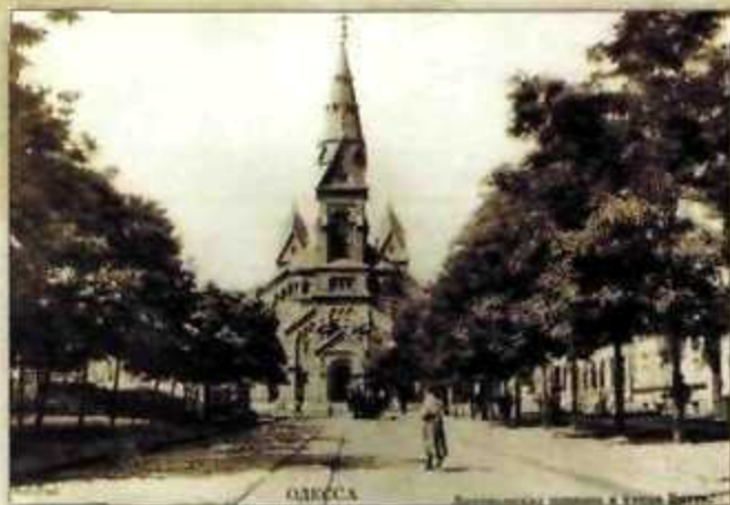
Второе здание кирхи (1897)
